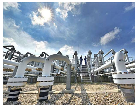
Der Erdgasspeicher Huntorf wird auf Wasserstoff umgerüstet.
