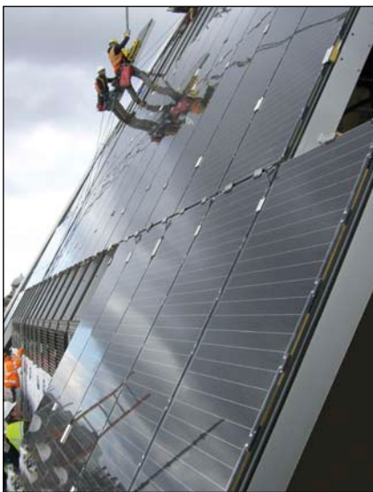
Bild 10: Bei der Montage der BIPV-Anlage an der Fassade des Gewerbegebäudes „The PEAK“ in London (34,4 kWp) stellten die Monteure geradezu künstlerische Fähigkeiten unter Beweis.
