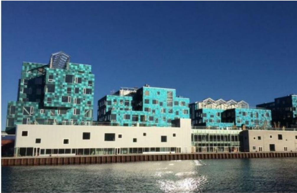
Neue Photovoltaik-Elemente lassen sich in Fassaden integrieren. Als besonders gelungenes Beispiel gilt die Copenhagen International School. © Philippe Vollichard/EPFL
