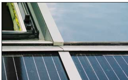
Bild 9: Hersteller Roto bietet mit seinem „Sunroof-System“ schon längere Zeit die Möglichkeit, in ein und demselben Rastermaß PV-Module, thermische Kollektoren sowie Dachfenster zu integrieren.
