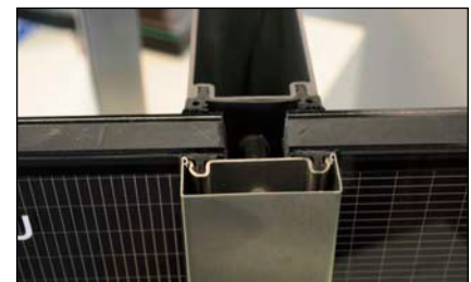
Bild 10: Die Pfosten-Riegel-Konstruktion nimmt die Kabel der Solarmodule auf und leitet sie verdeckt zum Wechselrichteranschluss. Module und die Glasscheiben sind mit Gummidichtungen zum Metallrahmen hin versehen.
